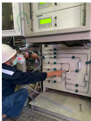
ใช้ N2 เพื่อตรวจเช็ครั่วของระบบ CEMs พร้อมใช้ทำ zero
